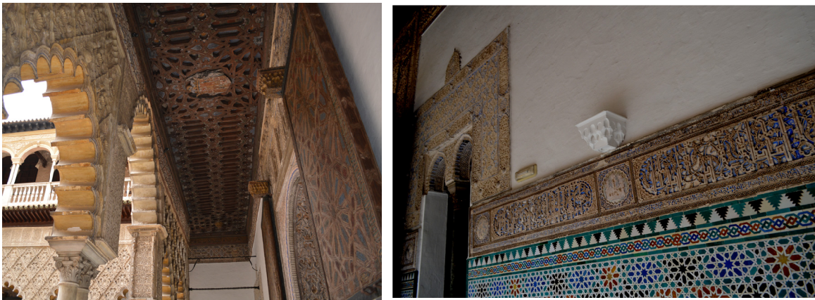
Figura 1. Patio de las Doncellas. Izquierda: alfarje de la zona Sur-Este. Derecha: detalle de la zona de yeserías del muro Sur-Este.
