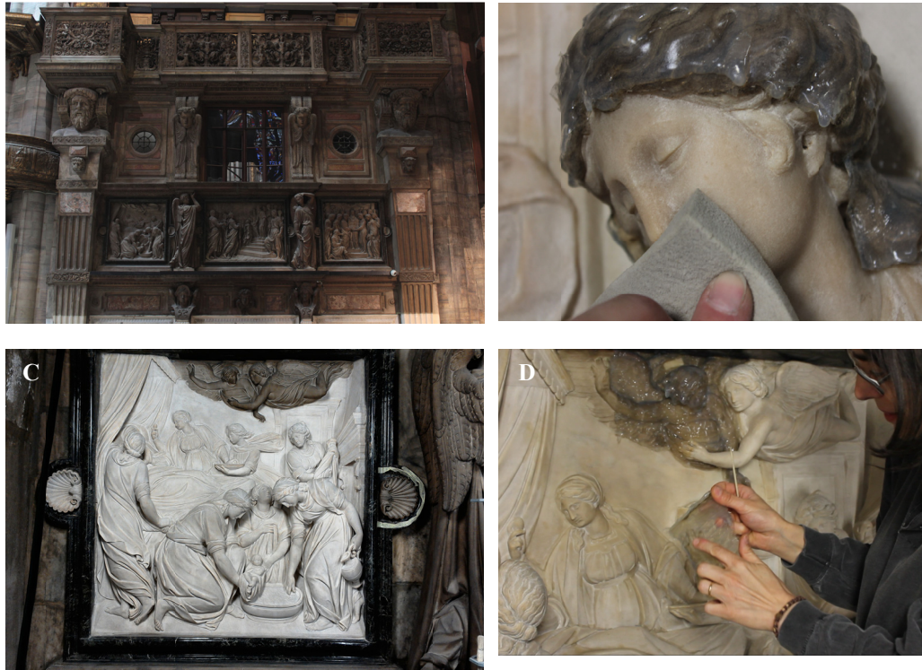
Figura 3. (A) Uno de los nueve sectores del trascoro de la catedral de Milán, antes de la limpieza. (B). Los depósitos de suciedad disgregados por el contacto con el gel se eliminan con una esponja. (C) Escena en proceso de limpieza. Con el gel de agar se puede seleccionar la zona a tratar sin tener que seguir un orden establecido. (D) Control de los depósitos absorbidos por el gel. © Veneranda Fabbrica del Duomo . Fotos: M. Anzani.
