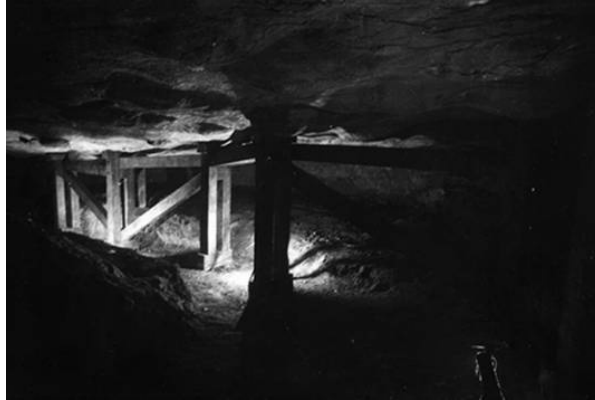
Figura 2. Entibado de madera en la Sala de Policromos. © Fototeca IPCE.
