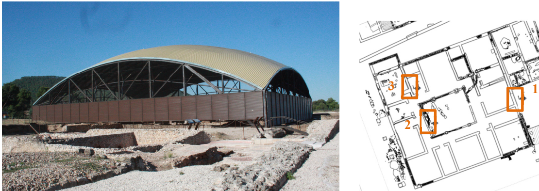
Figura 1. (Izquierda) Cubierta de la casa de los Grifos. (Derecha) Planta de la Casa de los Grifos y ubicaciones de los sensores.
